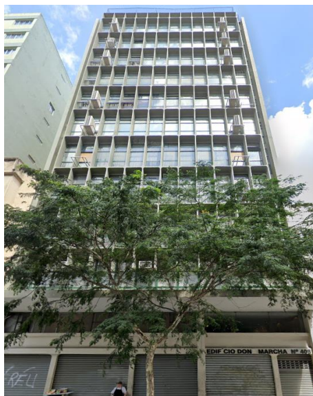
Figura 6 - Fachada do Edifício Dona Marcha
