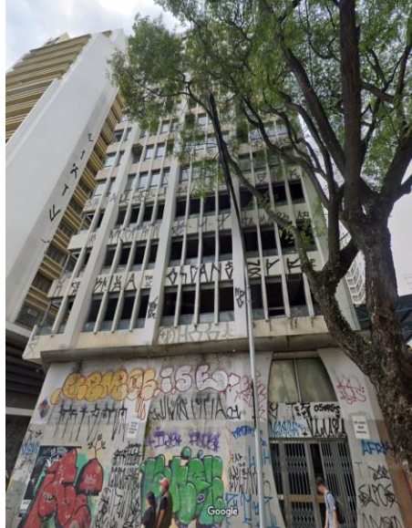
Figura 5 - Fachada do Edifício Taquari
